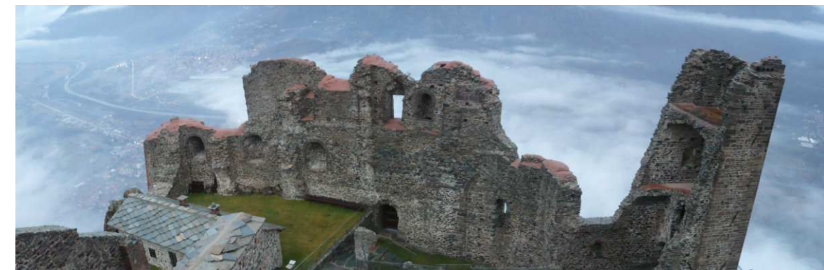
la torre della bell'Alda 🤖
