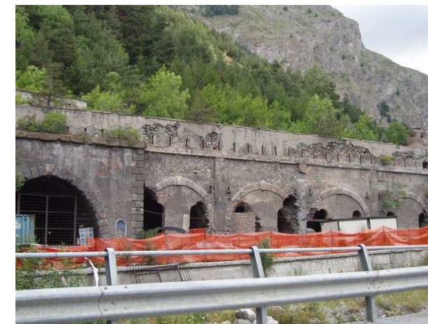
caserma difensiva tunnel ferroviario del Frejus
