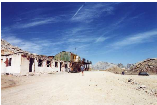
L'ex rifugio Ambim (ora demolito)
