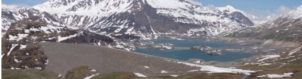
Grande diga e vecchie dighe
